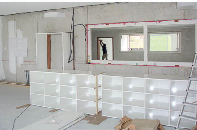
Montage einer längs durchlaufenden Schrankwand in einem Schulzimmer.
